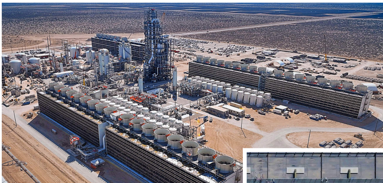
La plus grande installation au monde de capture directe du CO 2 de l'atmosphère, conçue par 1PointFive, STRATOS, actuellement en cours de développement dans le comté d'Ector, au Texas. Photos : Carbon Engineering Ltd.
